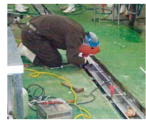
▲レベル出しボルトの切断作業
