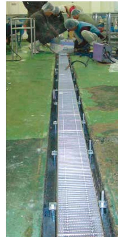
▲レベル出しボルトの切断作業
